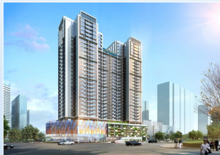
TÒA NHÀ THE LEGEND – HÀ NỘI Sàn mái sử dụng Neoproof PU W Khối lượng: 6.100m 2
