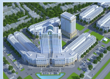
DỰ ÁN TỔ HỢP NHÀ Ở MỚI – THANH HÓA Sàn mái sử dụng Neoproof PU W Khối lượng: 5.700m 2
