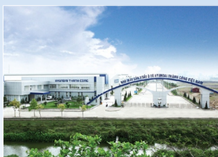
NHÀ MÁY HUYNH DAI – NINH BÌNH Sàn mái sử dụng Neoproof PU W Khối lượng: 3.800m 2 Sàn vệ sinh sử dụng Neoproof PU 360 Khối lượng: 720m 2
