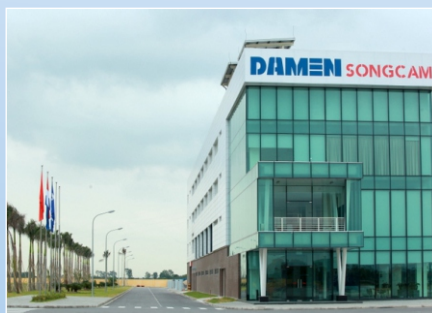
NHÀ MÁY DAMEN SÔNG CẤM – HẢI PHÒNG Sàn mái sử dụng Neoproof PU W Khối lượng: 20.000m 2
