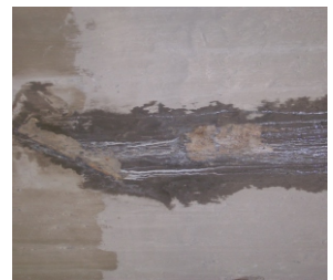
Trát lại bằng vữa sửa chữa Lanko 731
