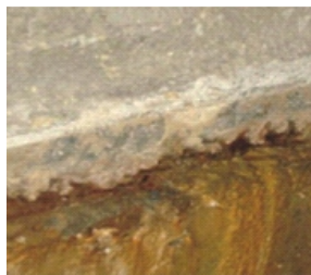
Đục mạch ngừng thi công
