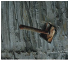
Lỗ ty, sắt chờ, sắt lõi trên tường chắn đất tầng hầm
