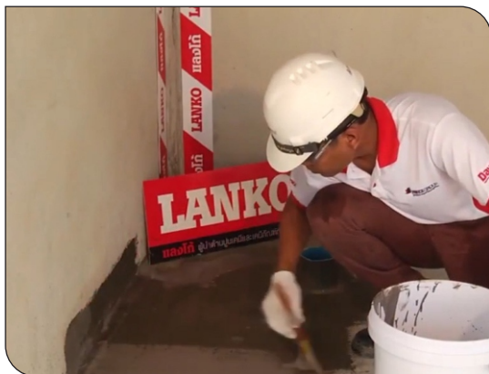
Thi công lớp thứ 2
