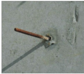
Lỗ ty, sắt chờ, sắt lõi trên tường chắn đất tầng hầm
