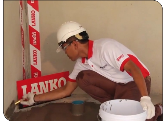
Thi công lớp thứ 1
