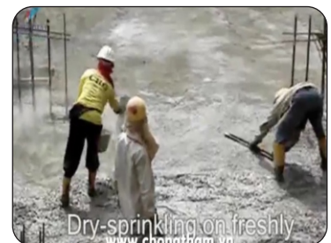
Thi công rắc lớp 2
