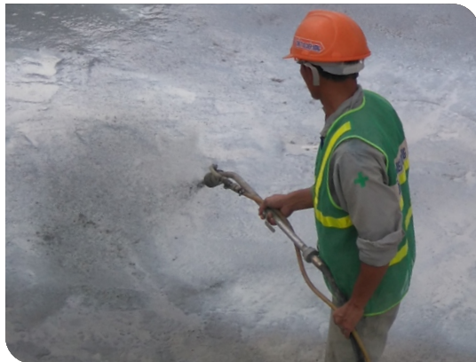
Thi công phun sàn tầng hầm
