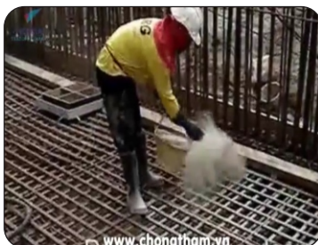
Thi công rắc lớp 1
