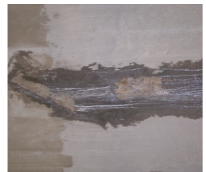
Trát lại bằng vữa sửa chữa Lanko 731
