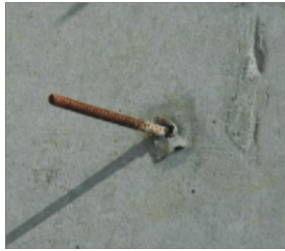
Lỗ ty, sắt chờ, sắt lồi trên tường chắn đất tầng hầm
