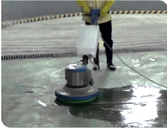
Vệ sinh bề mặt
