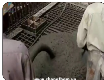
Đổ bê tông
