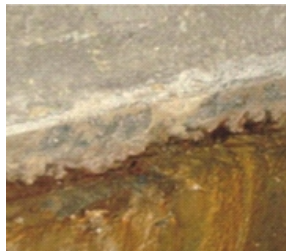
Đục mạch ngừng thi công
