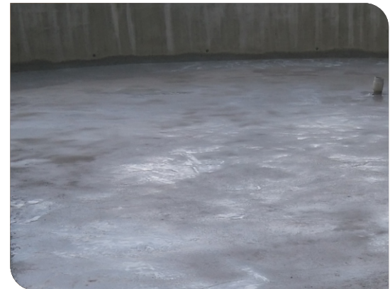
Bề mặt hoàn thiện
