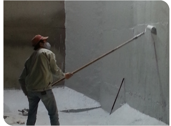
Thi công lăn vách tầng hầm
