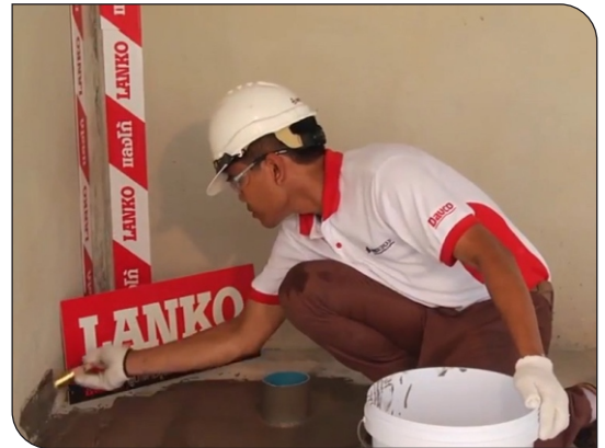
Thi công quét lớp thứ 1
