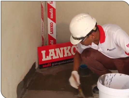
Thi công quét lớp thứ 2
