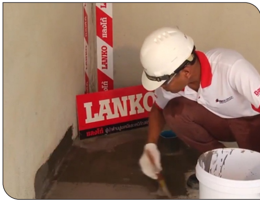
Thi công quét lớp thứ 2
