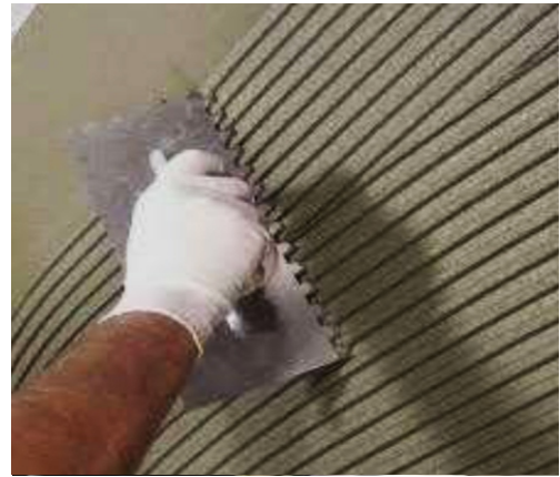
- Thi công với bay răng cưa cắt hình vuông cho gạch lớn.
