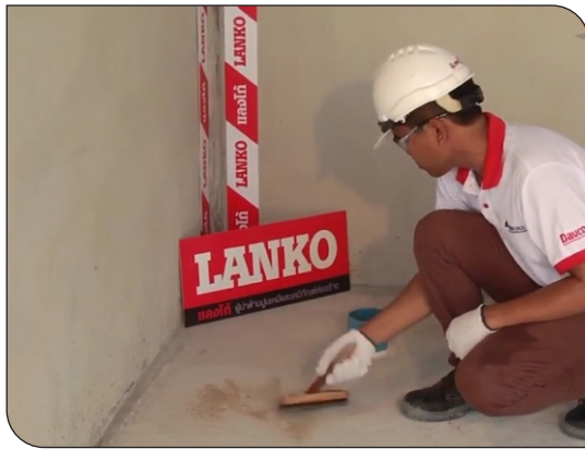
Chuẩn bị bề mặt
