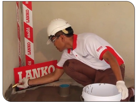
Thi công quét lớp thứ 1
