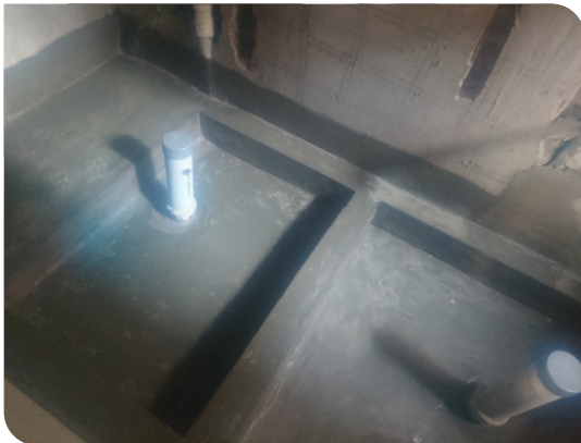
Thi công lớp thứ hai
