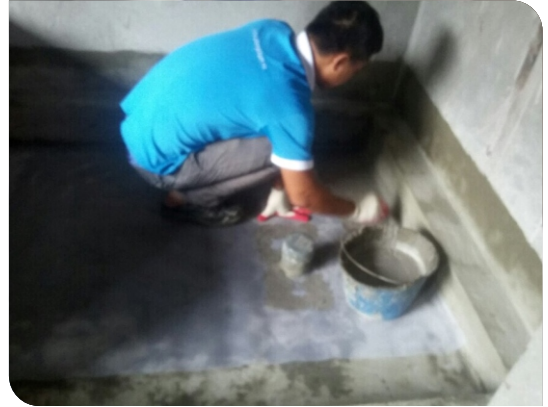
Thi công lớp thứ nhất
