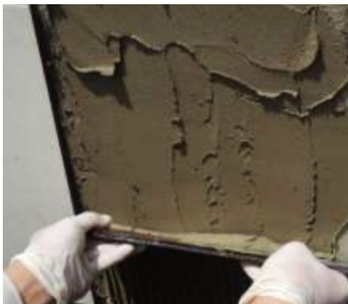
- Thi công với răng cưa cắt chữ "V" cho gạch nhỏ.
