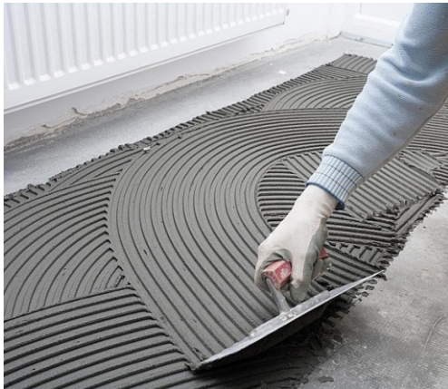
- Thi công với răng cưa chữ "V" cho gạch nhỏ.
