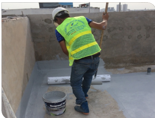
Thi công trải vải không dệt Neotextile®
