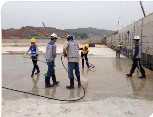
Vệ sinh làm sạch bề mặt
