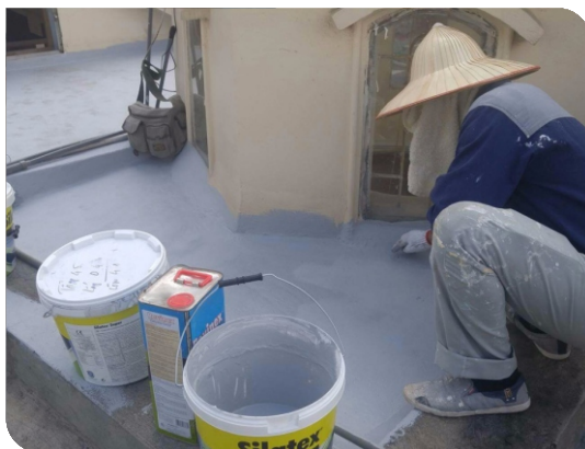
Thi công bằng chổi quét
