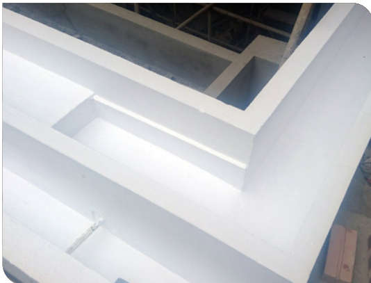
Thi công máng thoát nước
