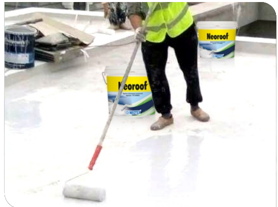
Thi công bằng con lăn
