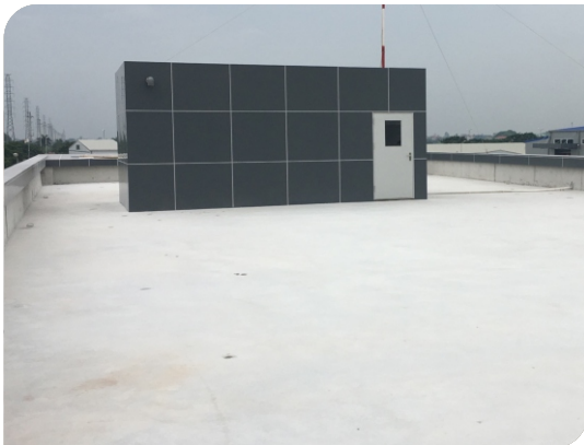
Vệ sinh bề mặt
